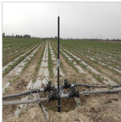
受控设备（阀门）+传感器：安装在条田里，受条田控制器控制。长期处于断电状态。[图 5]
